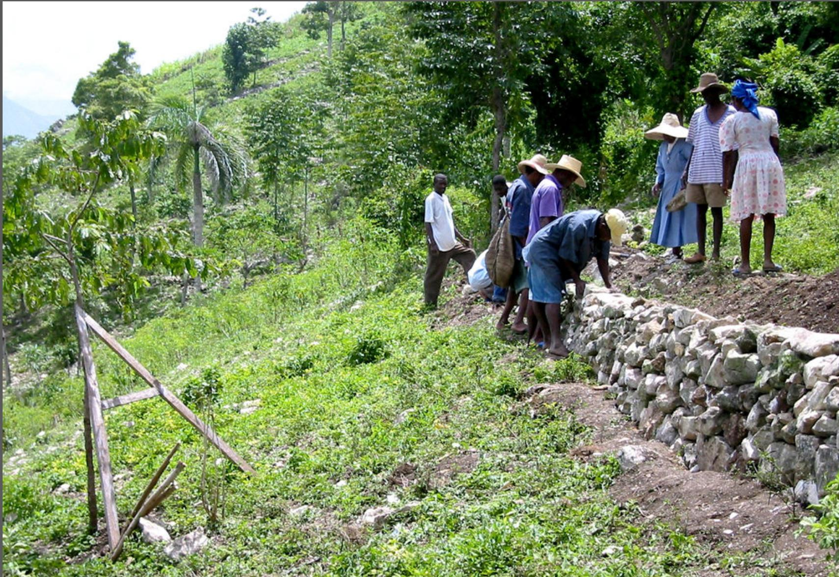
Zuerst müssen die abrutschenden Hänge befestigt werden. Als Material für die kleinen Stützmauern, die die Abhänge terrassieren, werden die herumliegenden Steine verwendet.
