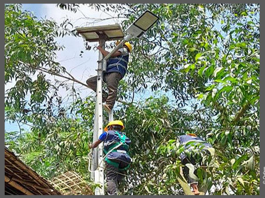
Hier sieht man die Installation einer neuen Straßenlampe. Ganz oben das Solarpaneel, rechts davon die nach unten gerichtete LED-Lampe. Die Speicherung des Sonnenstroms geschieht natürlich mit einer Batterie.
