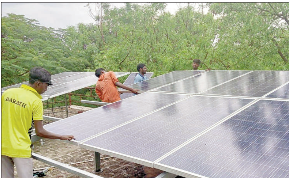
Die Solarpaneele werden auf dem Flachdach montiert.
